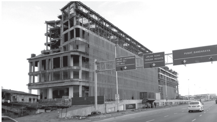
The Emporium @ Jln Tun Jugah underway
